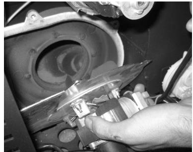
Figure 84 – a) Retirez les vis ; b) Retirez l'extracteur
