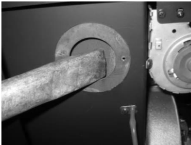
Figure 82 – a) Aspirez l'intérieur ; b) Nettoyez avec un écouvillon
